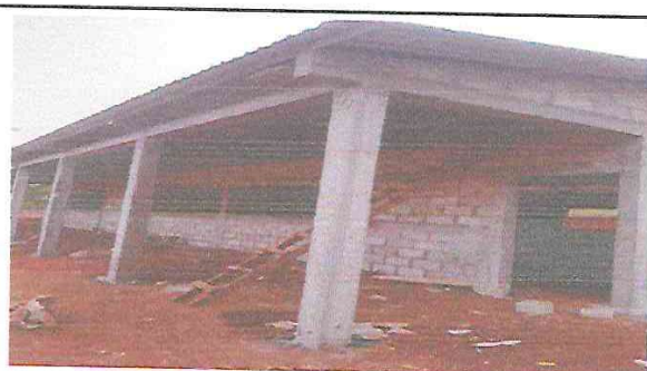
Foto 3: Instalación del techo de las dos aulas
