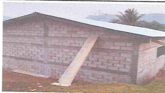
Foto 1: Se observa la finalización de la obra.
