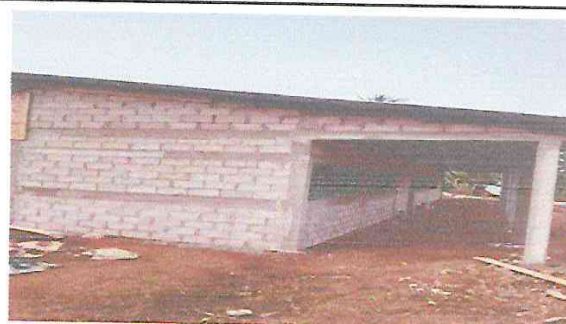
Foto 4: Se observa el corredor de las dos aulas
