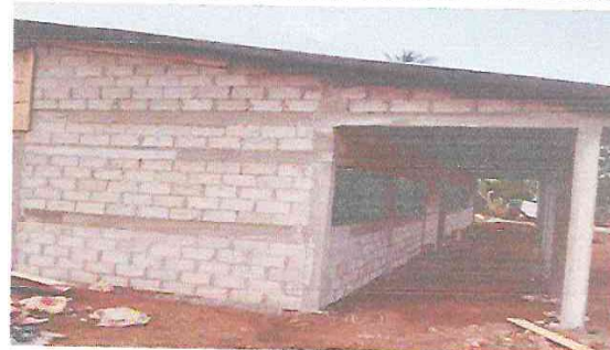
Foto 2: Se terminó de instalar el techo.
